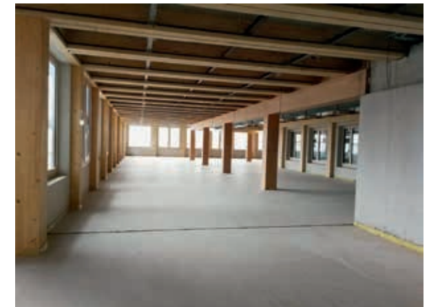
Abbildungen 30–31: Erstes Schweizer Holzhochhaus, Rotkreuz, Burkhard Meyer Architekten BSA, Stützen und Unterzüge aus BauBuche GL75 Fotos: Markus Bertschi
