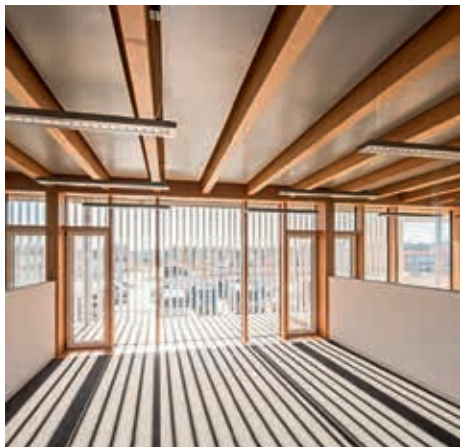
Abbildungen 17–20: Bürogebäude der euregon AG, Augsburg, lattkearchitekten bda, Skelettbau: Stützen, Haupt- und Nebenträger aus BauBuche GL75, Deckenplatte BauBuche Q Fotos: Eckhart Matthäus
