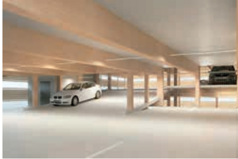
Abbildung 16: BauBuche Projektbeispiel / Visualisierung Parkhaus Unterzüge und Stützen aus BauBuche GL70, Deckenuntersicht aus BauBuche Platten. Forschungsprojekt der TUM.Wood unter Beteiligung der Professoren Hermann Kaufmann, Florian Nagler, Stefan Winter, Klaus Richter, Jan-Willem van deKuilen.
