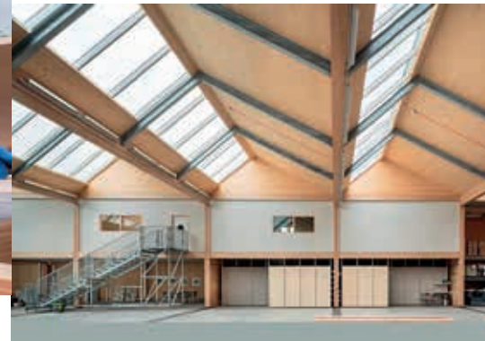
Abbildungen 23–25: Vitsoe Möbelfabrik, Royal Leamington Spa, Großbritannien, Architekt: Waugh Thistleton, Stützen, Haupt- und Nebenträger aus BauBuche GL75 Fotos: Dirk Lindner
