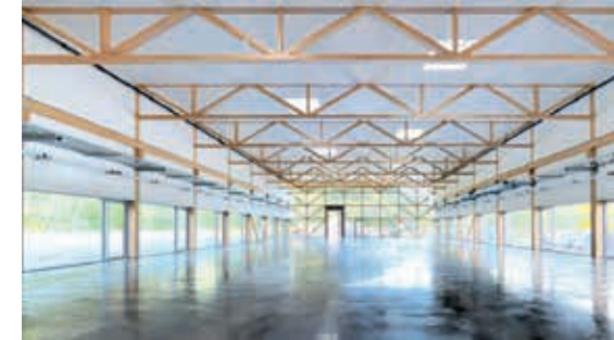
Abbildungen 21–22: Bürogebäude der euregon AG, Augsburg, lattkearchitekten bda, Skelettbau: Stützen, Haupt- und Nebenträger aus BauBuche GL75, Deckenplatte Bauche Q Fotos: Eckhart Matthäus
