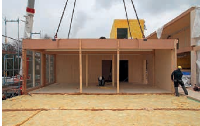
Abbildungen 26–27: Europäische Schule Frankfurt, Anbau in Modulbauweise, Architektur: NKBK Stützen und Unterzüge aus BauBuche GL75 Foto: Thomas Meyer
