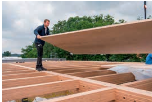
Abbildungen 17–20: Bürogebäude der euregon AG, Augsburg, lattkearchitekten bda, Skelettbau: Stützen, Haupt- und Nebenträger aus BauBuche GL75, Deckenplatte BauBuche Q Fotos: Eckhart Matthäus
