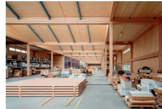
Abbildungen 23–25: Vitsoe Möbelfabrik, Royal Leamington Spa, Großbritannien, Architekt: Waugh Thistleton, Stützen, Haupt- und Nebenträger aus BauBuche GL75 Fotos: Dirk Lindner
