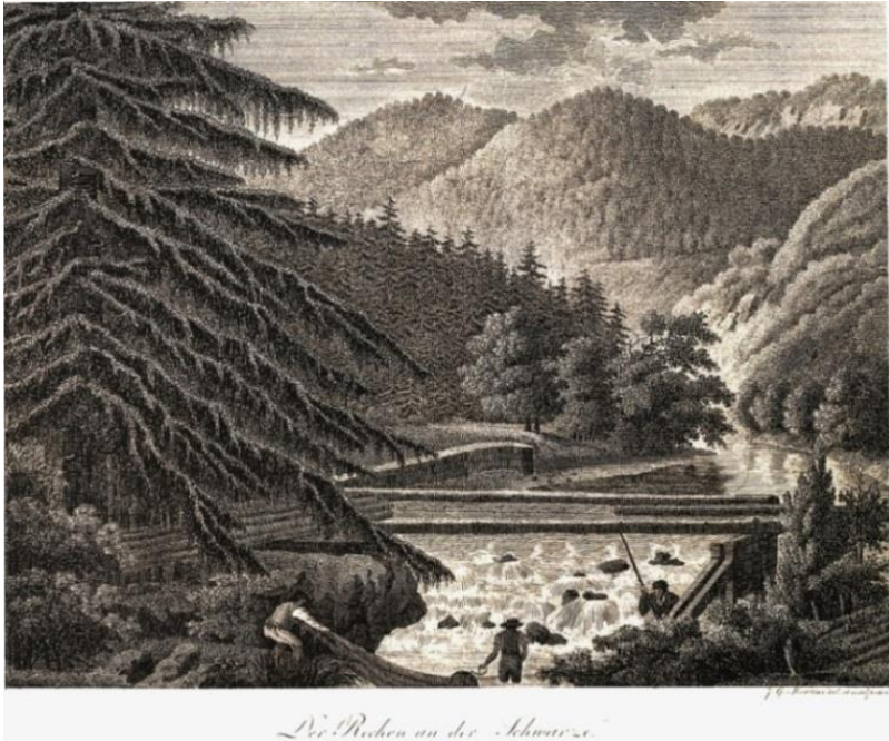
Abb. 6: Floßrechen an der Schwarza nahe der Buchhornmündung, Stich von Martini 1814 TLMH Rudolstadt, Sign. Gr. 89. 68
