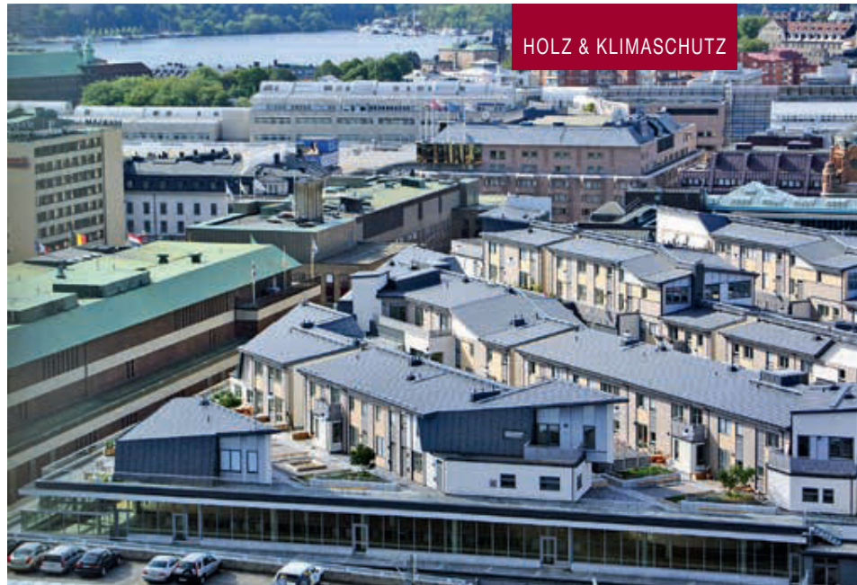
In Stockholm wurde die ehemalige Zentrale der schwedischen Postbank um eine Neubausiedlung von 60 zweigeschossigen Reihenhäusern in Holzbauweise aufgestockt. Das ungewöhnliche Vorhaben ließ sich nur unter Ausnutzung des niedrigen Gewichts von Bauteilen aus Holz realisieren. (Foto: Equator Arch.)
