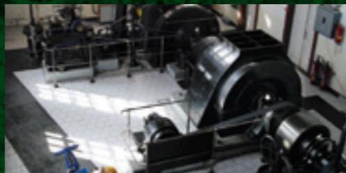
Im Werksgebäude ist die Pelton-Turbine mit einer Leistung von 1500 kW installiert. Der Damm am Úhlava Fluss schließt das untere Ausgleichsreservoir mit einem Volumen von 25 000 m<sup>3</sup>. Seit 1960 ist der Pumpbetrieb eingeschränkt. Im Jahr 2005 wurde der Maschinenraum mit einem neuen Turbogenerator mit einer Pelton-Turbine mit einer Leistung von 370 kW ausgerüstet.
