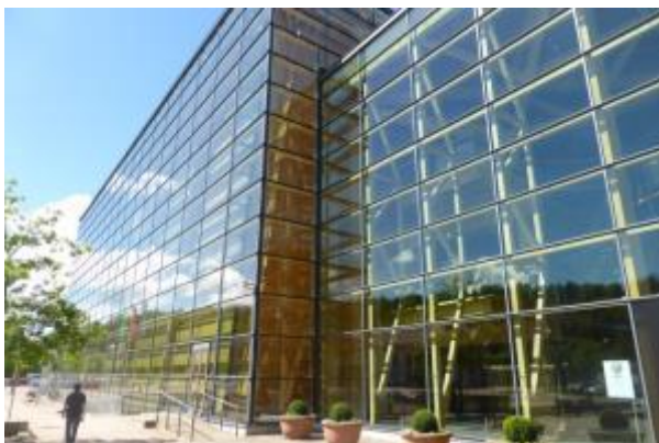
Abbildung 21: Glashülle um die Holzkonstruktion der der Sibeliushalle in Lahti
